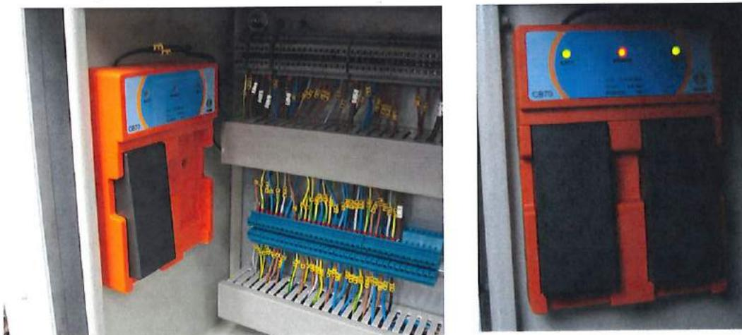
Figuras nº6.11-Cargador baterías control-remoto
