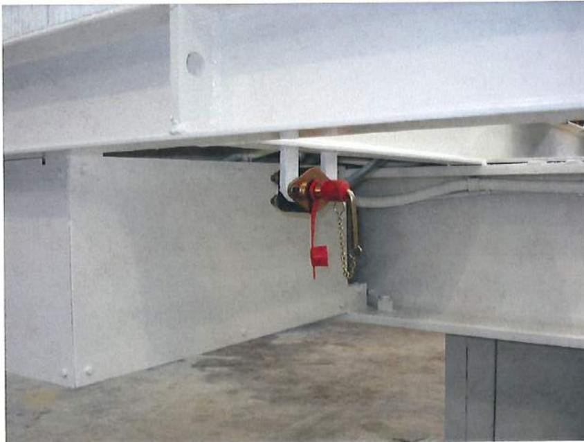
Figura n°6.9.-Seccionador batería
